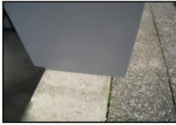
Posez l'ensemble de boîtes aux lettres sur le muret de façon centrée (le mur doit avoir une largeur minimum de 200 mm).
