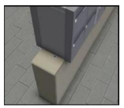
**1.** Posez l'ensemble de boîtes aux lettres sur le muret de façon centrée (le mur doit avoir une largeur minimum de 200 mm).
